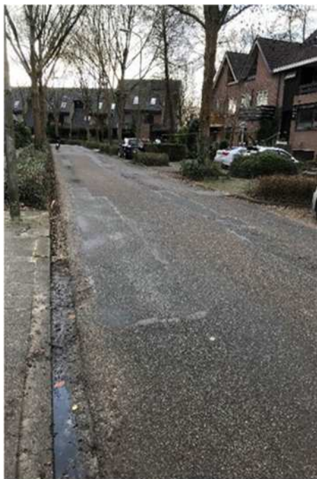
O.a. het slechte wegdek van de Rivierenlaan toont de noodzaak aan van de start van de laatste fase
