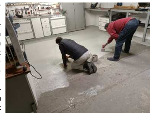
De laatste loodjes, het schilderen van de vloer
