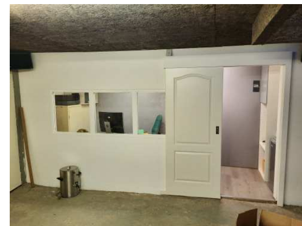
Het geheel vernieuwde kantoor met schuifdeur
