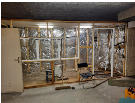
De materiaalbeheerders zijn snel aan de slag gegaan met het opknappen van de ruimte
