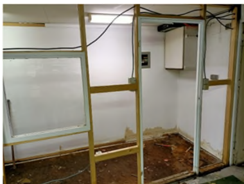
Het frame voor de wanden van het kantoor
