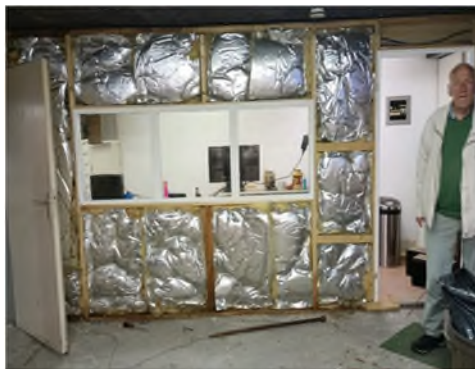
Gevuld met isolatiemateriaal
