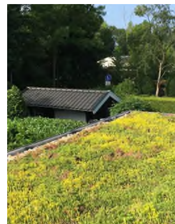
Dak aan de Duivestein.
