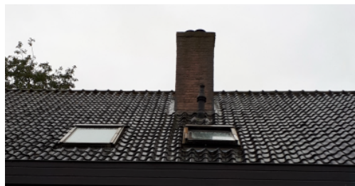
Enkele van de te vervangen dakramen
