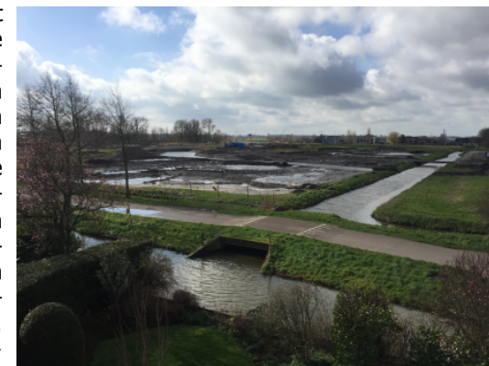
De werkzaamheden in Tuindershof zijn gestart
