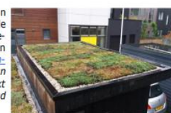
Sedumdak op schuur
