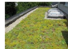
Sedumdak op platdak
