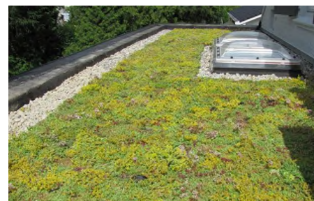
Sedumdak op platdak
