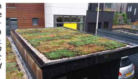
Sedumdak op schuur
