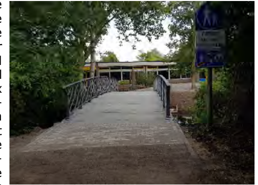
Vernieuwde brug bij de Eem
