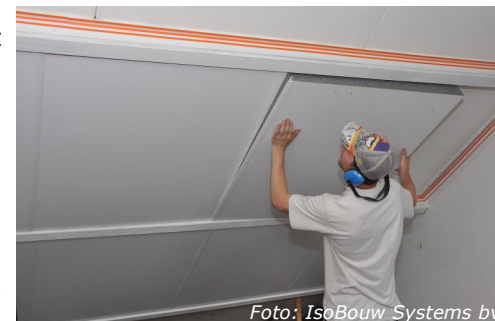
Isoleren aan de binnenzijde.
