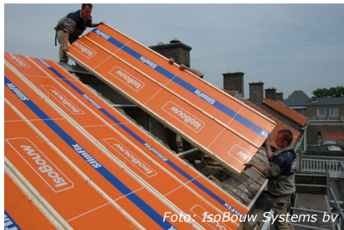
Isoleren aan de buitenzijde.
