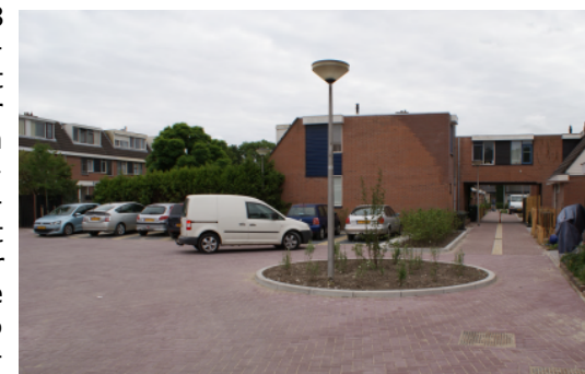
De bewoners van Fase 6 zijn tevreden over de werkzaamheden en het resultaat
