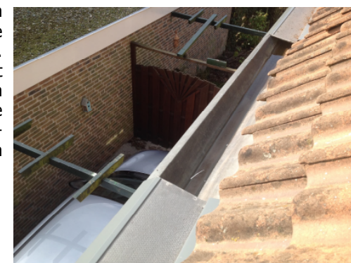
Zo ziet het eruit na montage (het middelste paneel is voor de duidelijkheid weggelaten)
